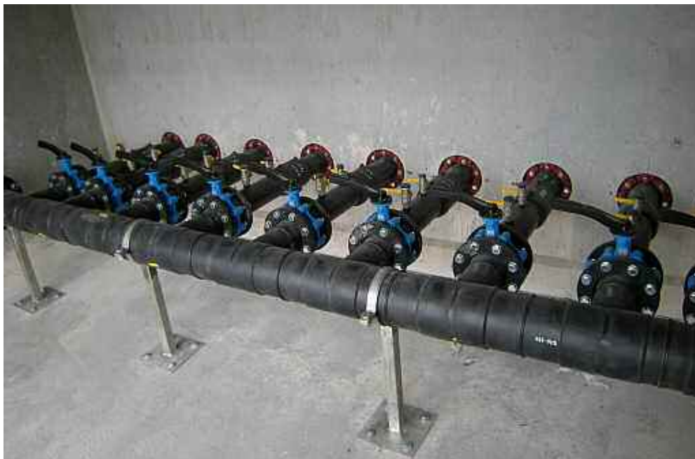
Abbildung 7 Im Modul angeordnetes zusätzliches Verteilerbauwerk
