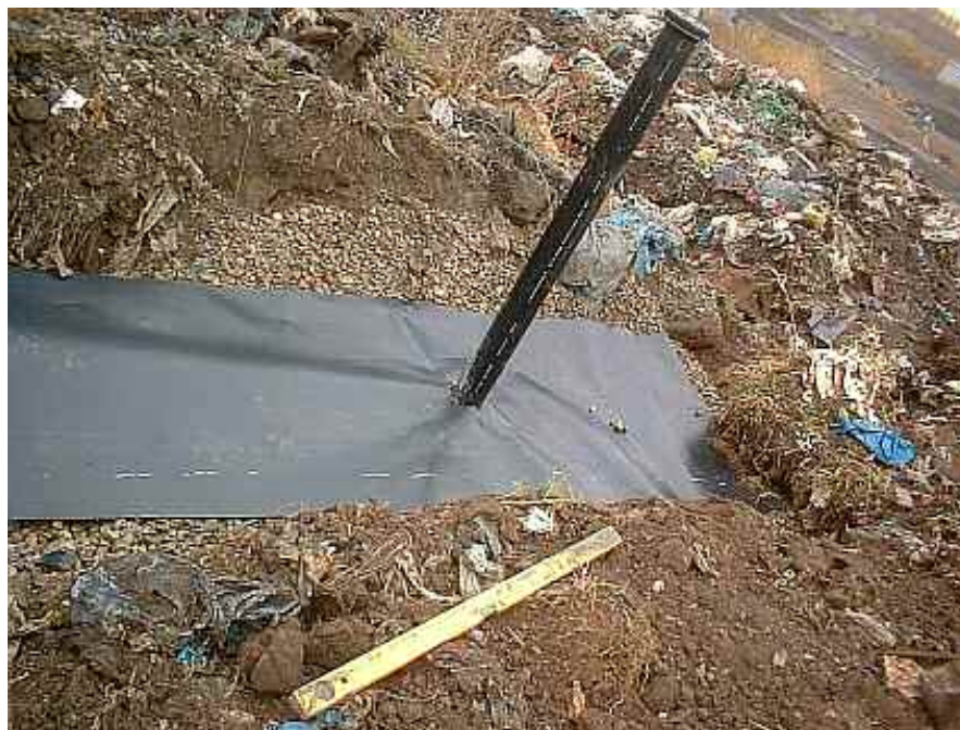
Abbildung 8 Füllstandsanzeige am Ende einer Rigole
