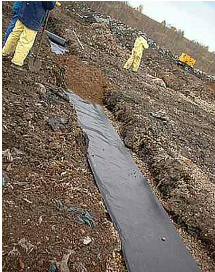
Abbildung 6 Infiltrationsrigole während der Bauphase
